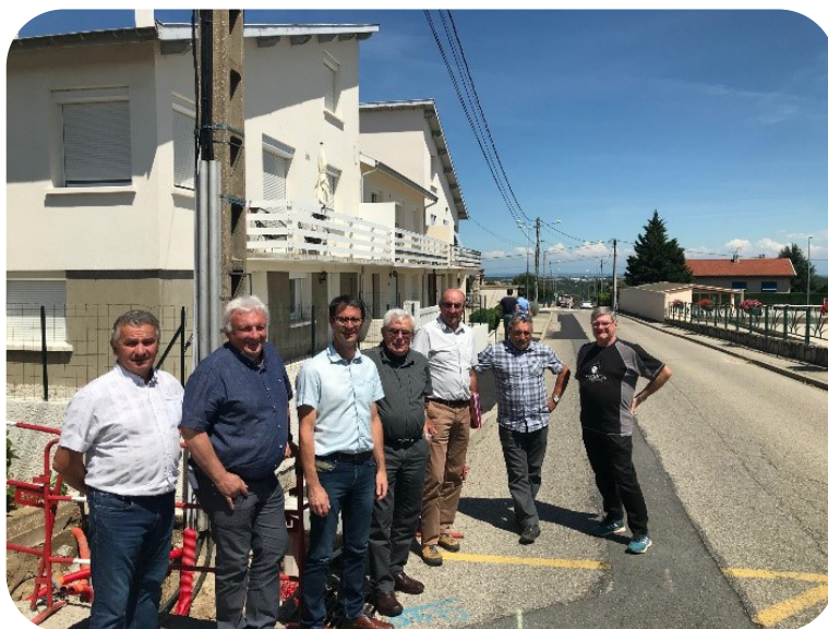
Visite de chantier à Roiffieux.
