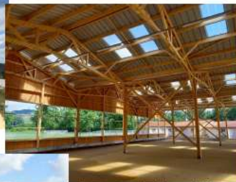
Couverture du boulodrome de Mauves
