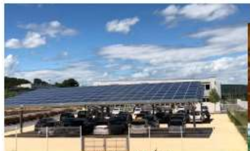
Ombrières de la Draga
